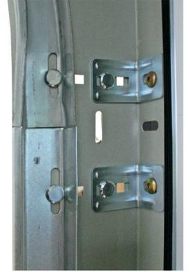
A l'aide de boulons M8 et de 2 equerres de maintien , fixez le profil C derrière le rail horizontal
